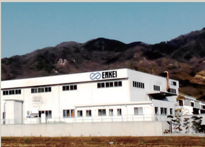
エンケイマカベの社屋・工場外観
